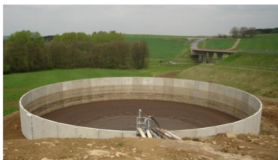
Réservoir à lisier. Source : IAK
